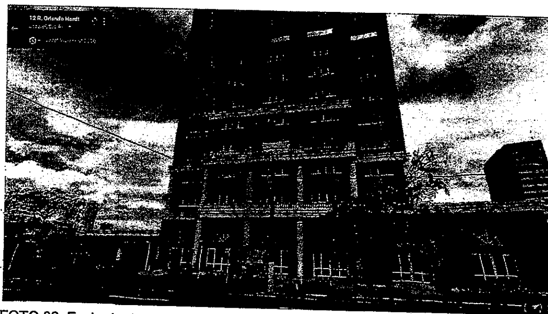
FOTO.02: Fachada do Imóvel na Rua Orlando Hardt, nº 125, Centro, Jacareí - SP.
