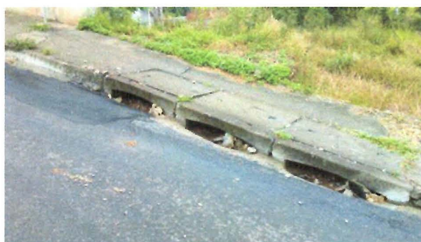
FOTO: Bocas de lobo entupidas.
