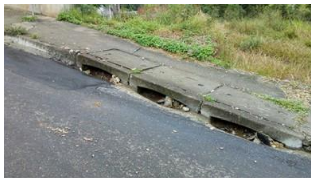
FOTO: Bocas de lobo entupidas.
