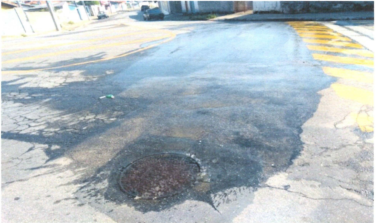
Figura 1 bueiro com vazamento
