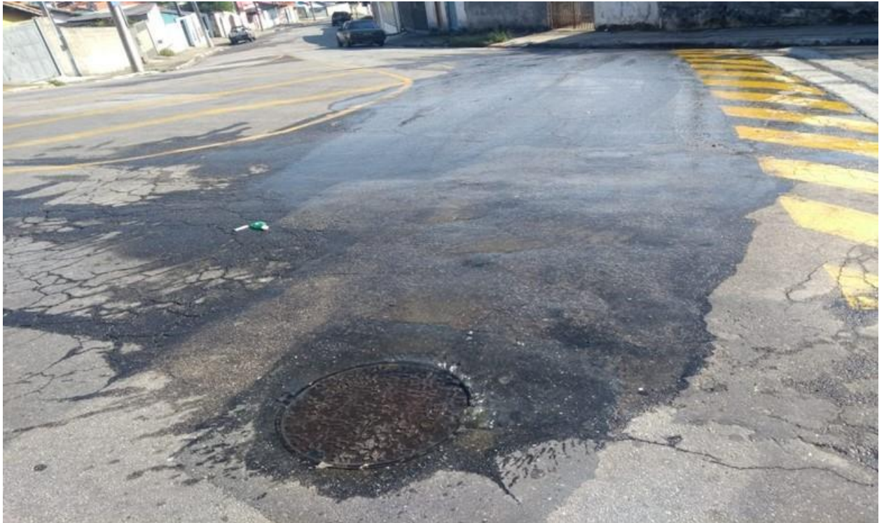
Figura 1 bueiro com vazamento
