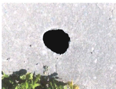
FOTOS 7, 8 E 9: Bueiro quebrado e buraco fundo na calçada da viela ao lado da Rua Bertioga.
