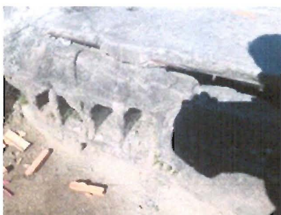
FOTOS 7, 8 E 9: Bueiro quebrado e buraco fundo na calçada da viela ao lado da Rua Bertioga.
