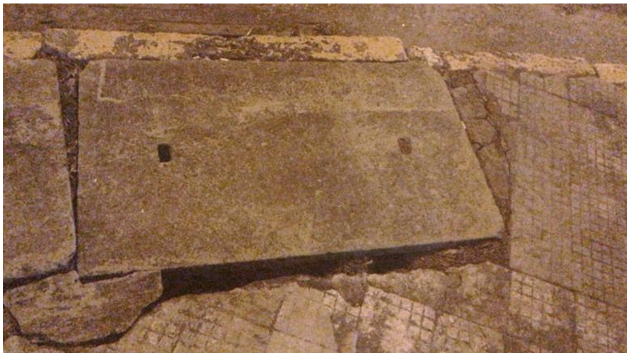
FOTO: Tampa de boca de lobo solta, localizada no Jardim Liberdade.
