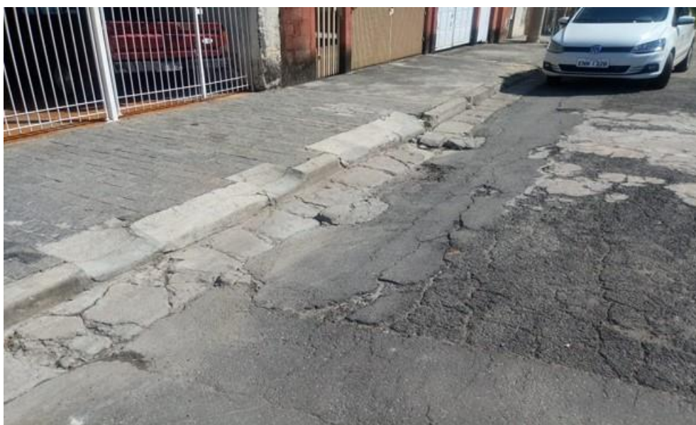
Figura 2 - operação tapa-buraco
