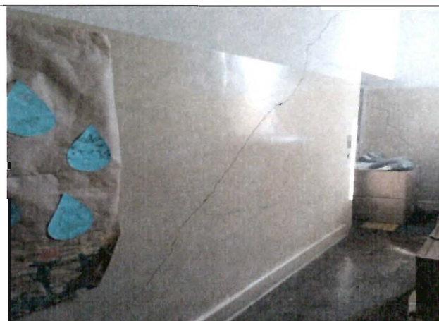
Foto 04 – Rachadura diagonal na parede do elevador
