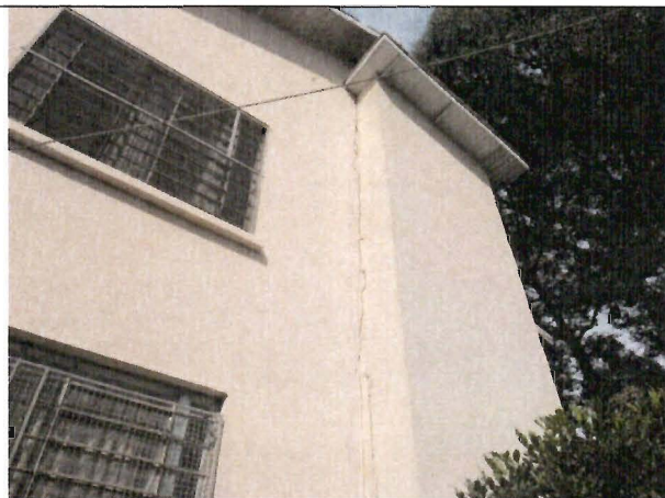
Foto 07 – Rachadura externa à parede do elevador
