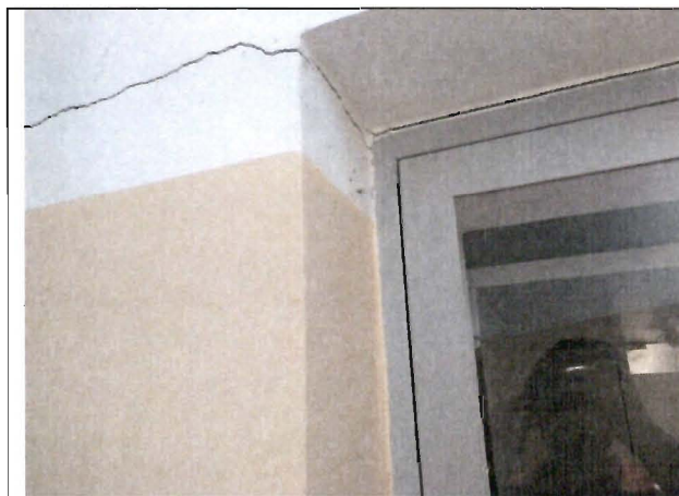
Foto 03 – Trinca horizontal na entrada do elevador
