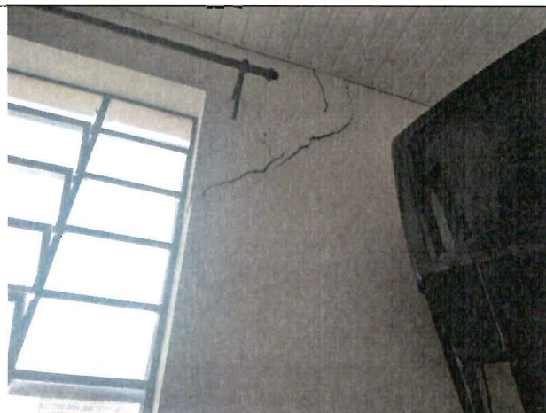
Foto 08 – Rachadura em sala em frente à entrada do elevador.
