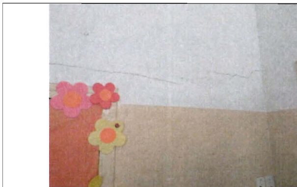
Foto 01 – Fissura em parede do corredor
