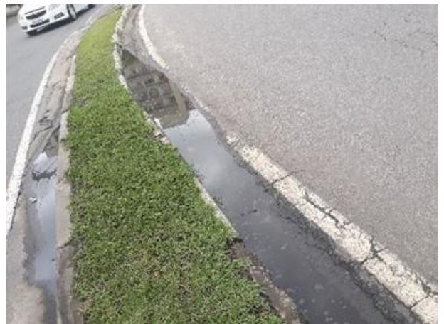
Empoçamento no canteiro central
