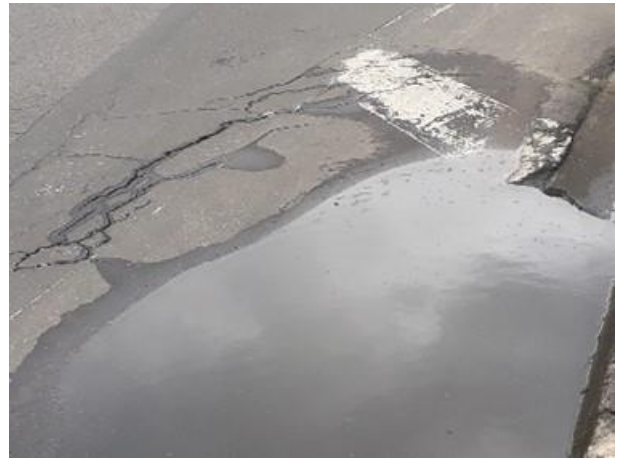
Rachaduras e afundamento
