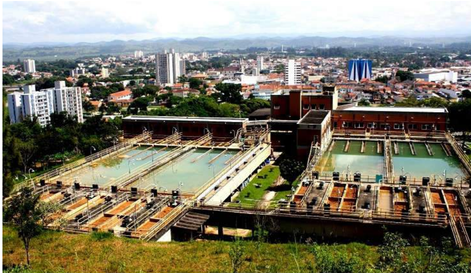
Figura 17: Estação de tratamento do SAAE
