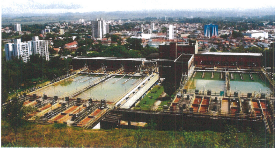
Figura 17: Estação de tratamento do SAAE
