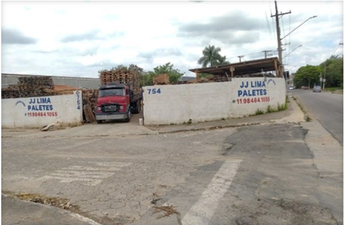
Foto 1: Depósito na Avenida Azênio de Azevedo Chaves, nº 754.
