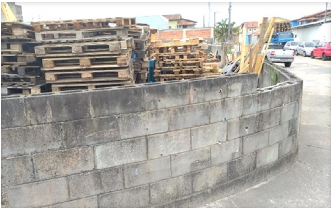
Foto 2: Depósito defronte do nº 754 da Avenida Azênio de Azevedo Chaves.
