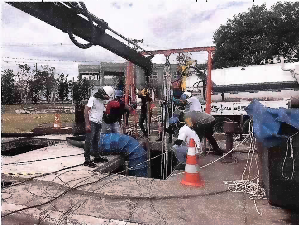
Foto 03 – Içamento de uma das bombas avariadas no poço da EEE Pq. dos Sinos.
