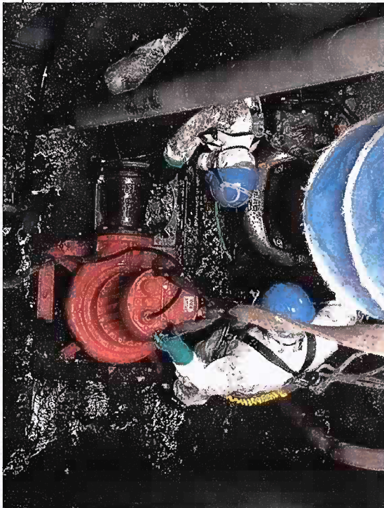
Foto 03 – Içamento de uma das bombas avariadas no poço da EEE Pq. dos Sinos.
