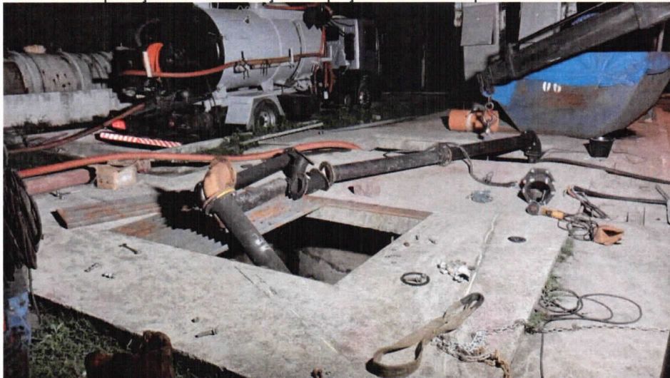
Foto 09 – Operação de substituição do poço da EEE Parque dos Sinos em 03/06/2022.
