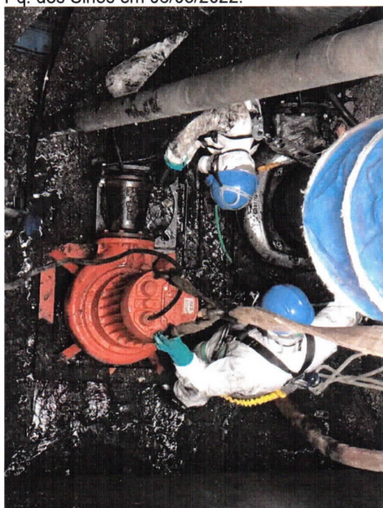
Foto 04 – Içamento de uma das bombas avariadas no poço da EEE Pq. dos Sinos em 07/05/2022.
