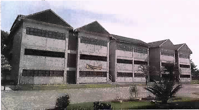
Fachada EMEI Guaraci da Rocha Simplício
