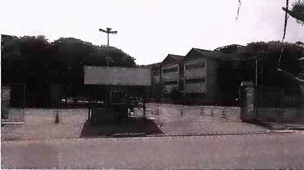
Fachada – Estrada do Limoeiro
