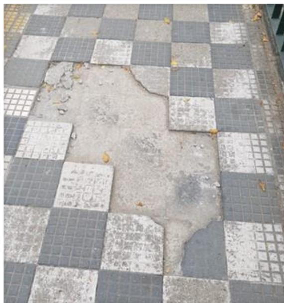
Sugerimos que o atual calçamento seja substituído por concreto, dada a trepidação da ponte.
