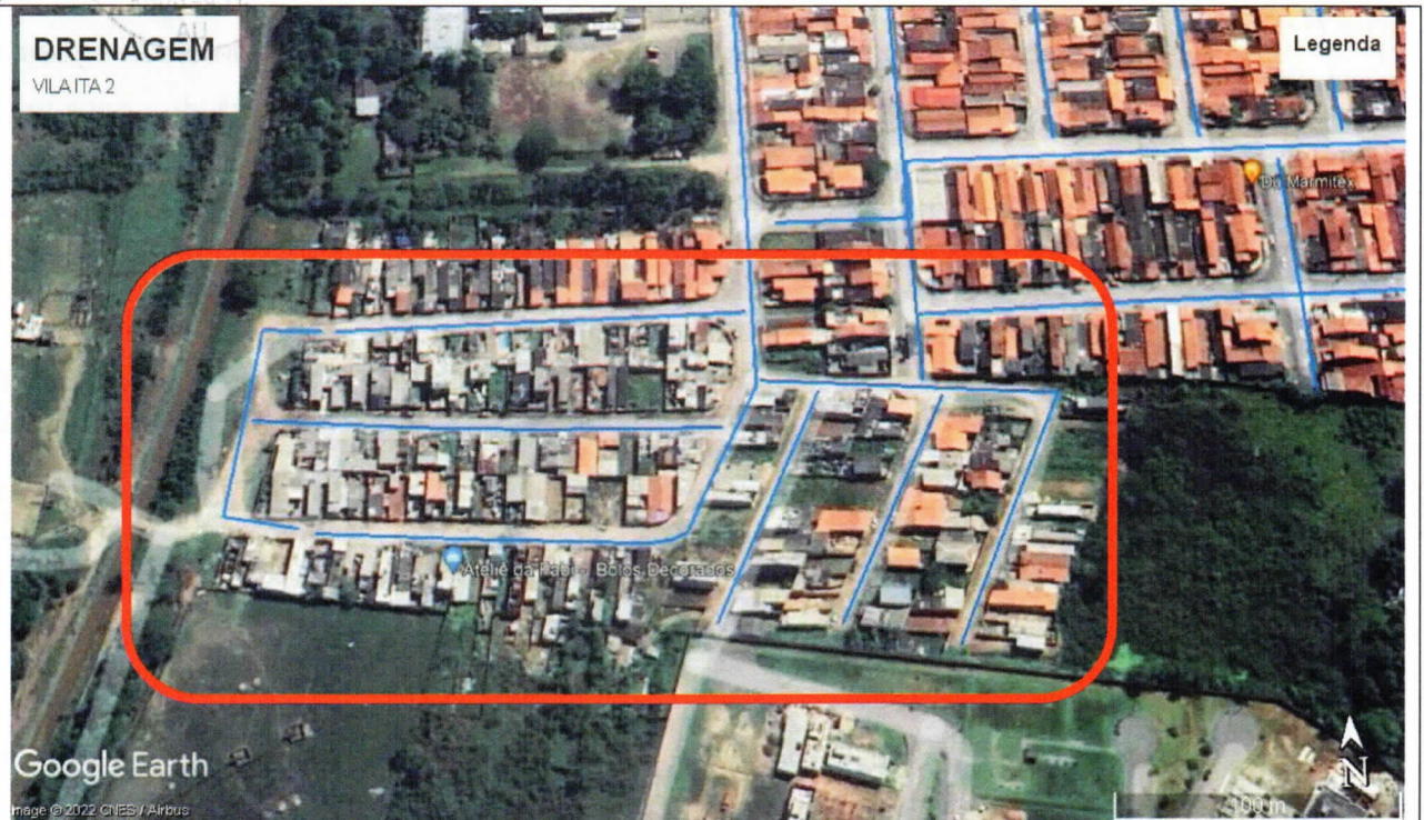
Foto 15: Local onde há problemas de inundação
