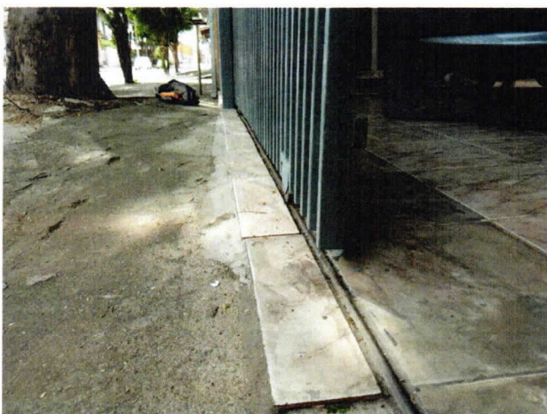
Foto 8. Portão funcionando adequadamente.
