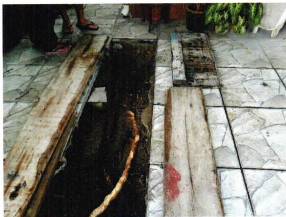
Foto 3. Vista de raízes sob o piso cerâmico. Raízes claras da Primavera (mais finas), e escuras da Sibipiruna (mais grossas).
