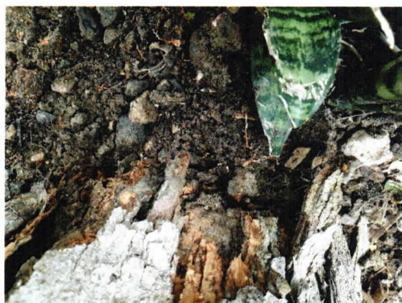
Foto 7. Vista de cupins na região da base.
