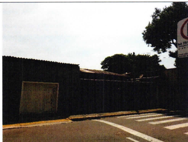
Foto 3. Presença de caixa de sistema drenagem no lado direito.
