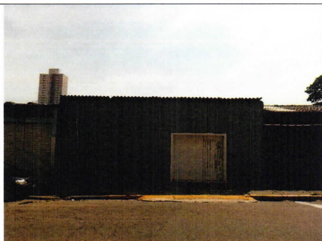
Foto 1. Vista frontal da calçada do imóvel da interessada.
