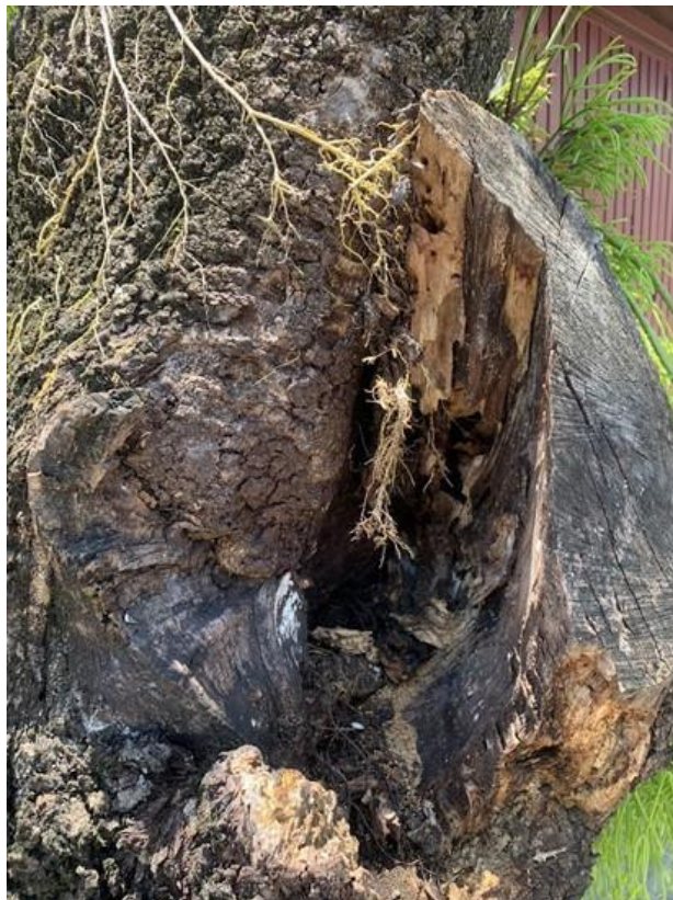
Fotos 1, 2 e 3: Rua Pedro Vergueiro, na altura do nº 70, no Bairro Cidade Jardim
