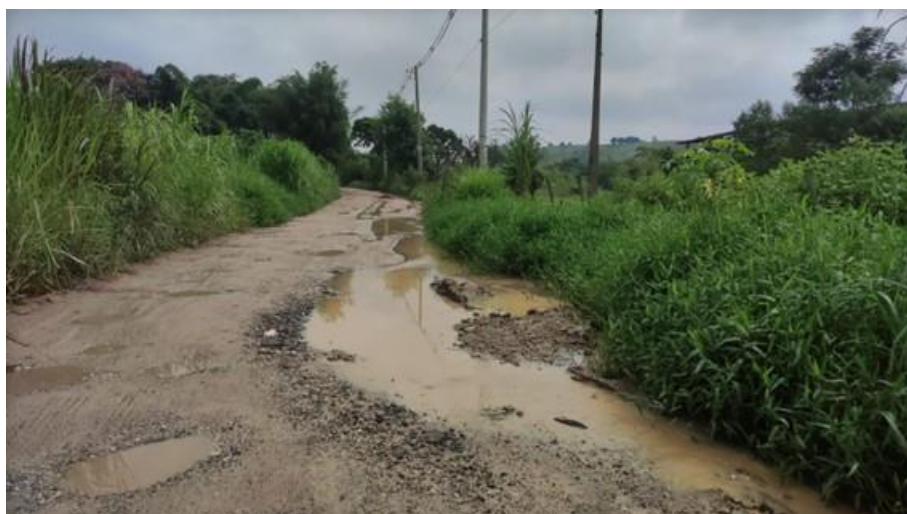
Fotos 4, 5 e 6: Estrada do Rio Comprido
