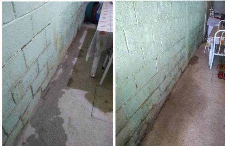
Conforme constatamos, a moradora está sofrendo com problema muito sério de infiltração no interior de sua casa após esta obra. Solicitamos providências urgentes, uma vez que se trata inclusive de questão de saúde, pois a infiltração está provocando mofo nas paredes.
