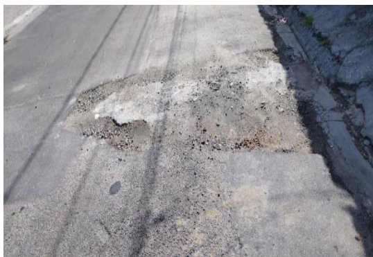
1. Próximo ao nº 92 da Rua Oakland
