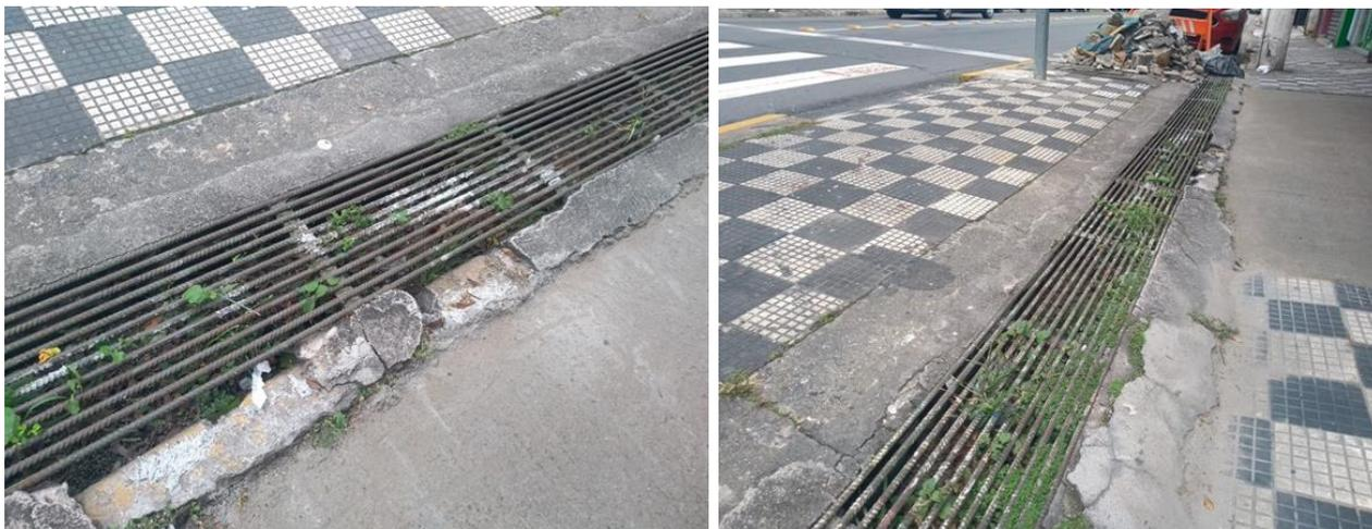
Em razão da ausência de limpeza dessas canaletas, o acúmulo de mato e sujeira vem causando represamento de água em frente aos comércios instalados na localidade nos períodos de chuva.
