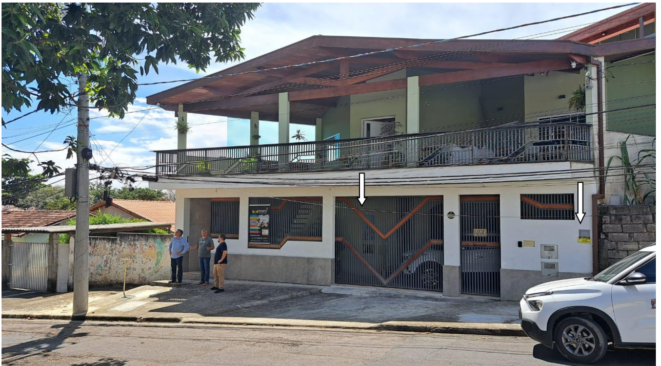
FOTO 02 - FIO SOLTO A MEIA ALTURA
