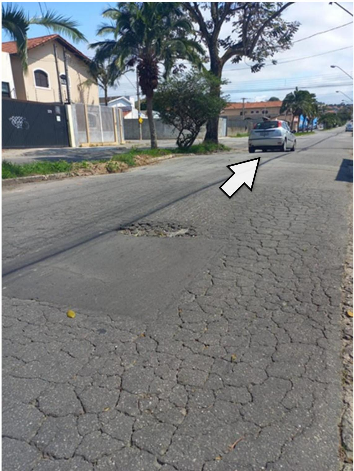
**Foto:** No local apontado pela seta, onde o veículo está passando, existe um grande desnível da via.
