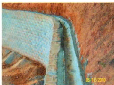
Foto 12 – Execução de canaleta sobre o muro Terrae
