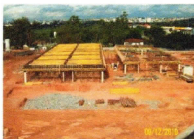
Foto 30 – Cimbramento e formas do EMEF
