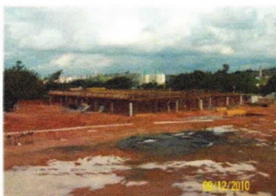
Foto 29 – Cimbramento e formas do EMEF
