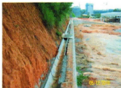
Foto 15 – Execução de canaleta sobre o muro Terrae
