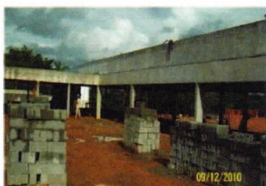
Foto 31 – Estrutura de concreto EMEI
