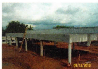
Foto 32 – Estrutura de concreto EMEI
