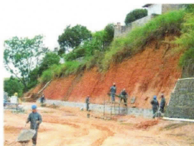
Foto 05 – Execução de muro Terraê
