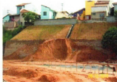
Foto 26 – Execução de escada hidráulica
