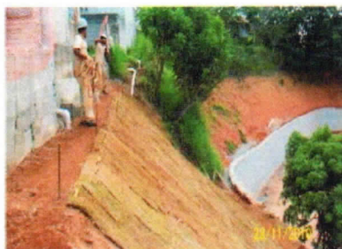
Foto 07 – Plantio de grama em talude
