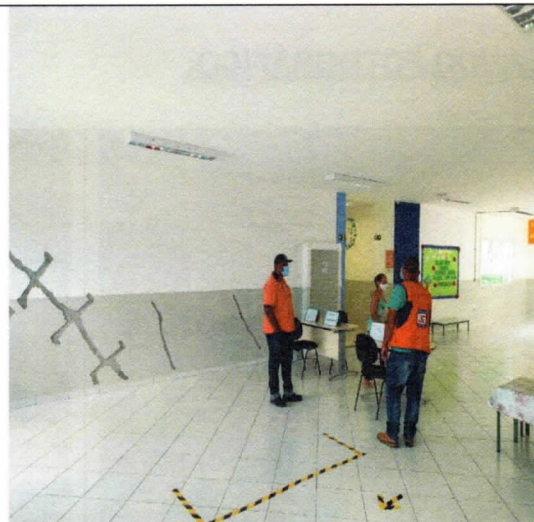
Foto 06 – Vista das obras de reparo na área comum;
