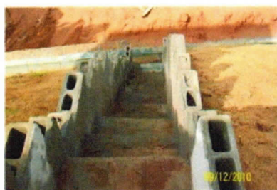
Foto 25 – Execução de escada hidráulica
