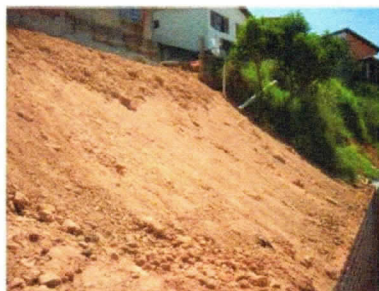
Foto 02 – Talude sobre o muro Terraê
