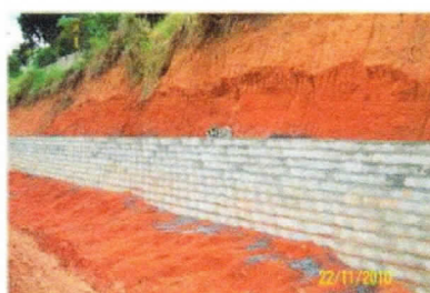
Foto 09 – Execução de muro Terraê
