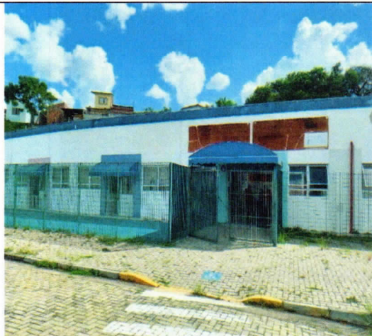
Foto 01 – Vista geral da Creche Escola;
