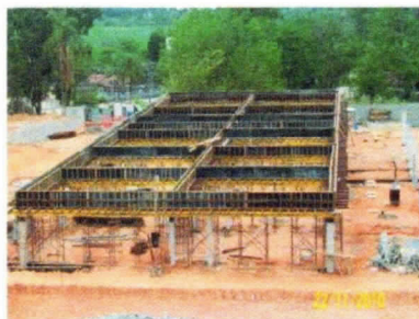
Foto 28 – Cimbramento e formas do EMEF
