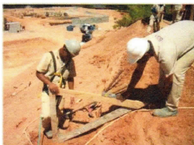
Foto 01 – Acerto manual do talude sobre o muro Terraê
