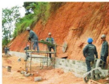
Foto 06 – Execução de muro Terraê
