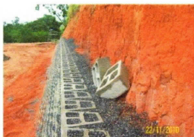
Foto 10 – Execução de muro Terraê
