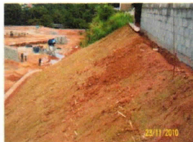
Foto 08 – Plantio de grama em talude
