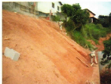
Foto 04 – Acerto manual do talude sobre o muro Terrae.
