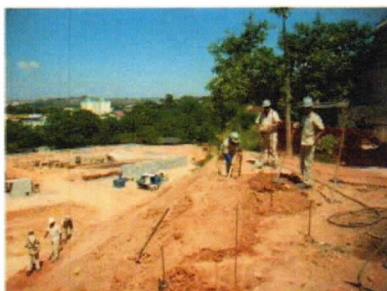
Foto 03 – Acerto manual do talude sobre o muro Terrae.
