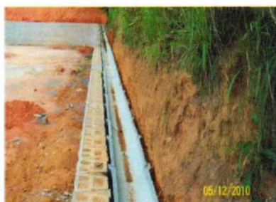
Foto 11 – Execução de canaleta sobre o muro Terrae
