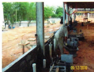
Foto34 – Alvenaria de vedação EMEI
