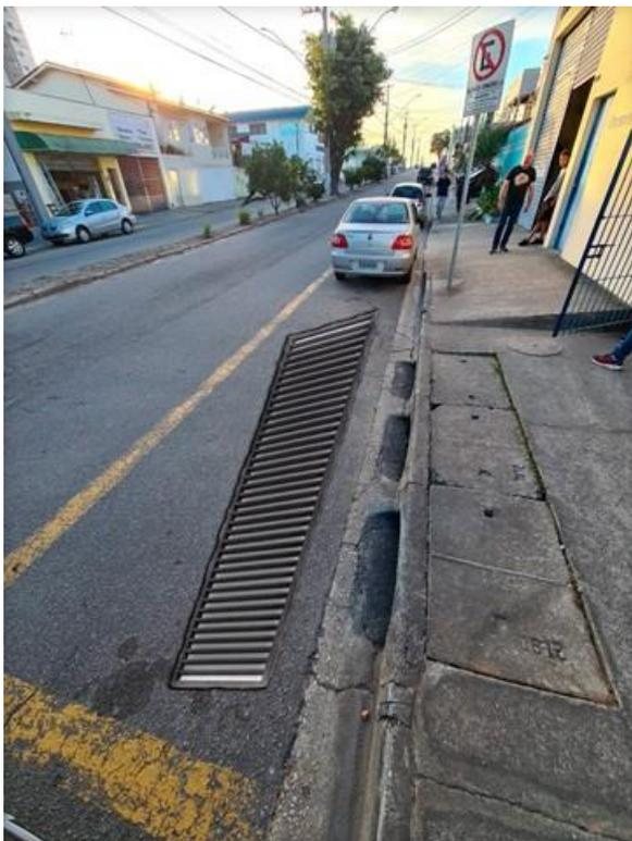
*Foto 3: Simulação do local com grelhas de drenagem*
