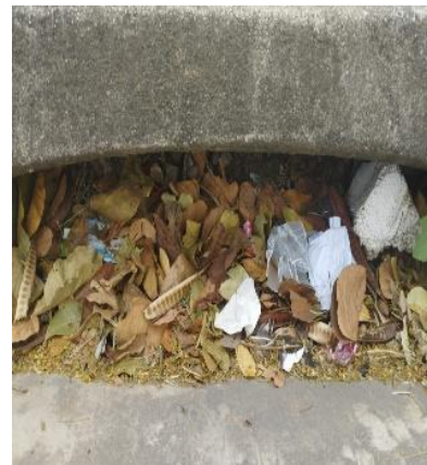
Próximo ao nº 46 da Avenida Rômulo Rossi
