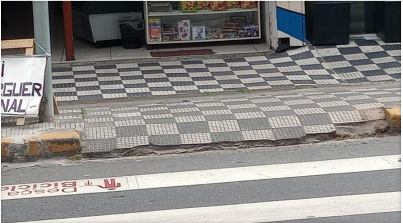
*Foto 1: Guia rebaixada necessita de readequação*
