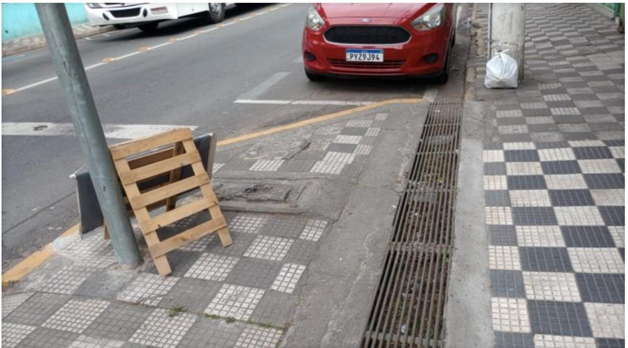
*Foto 2: Grelhas para escoamento de águas pluviais com acúmulo de resíduos sólidos*
