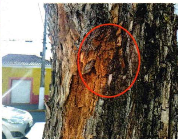
Foto 38. Presença de formigas carpinteiras.
