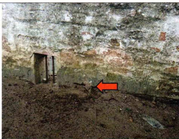
Foto 48. Raiz entre a alvenaria do muro de divisa, porém não há trincas.
