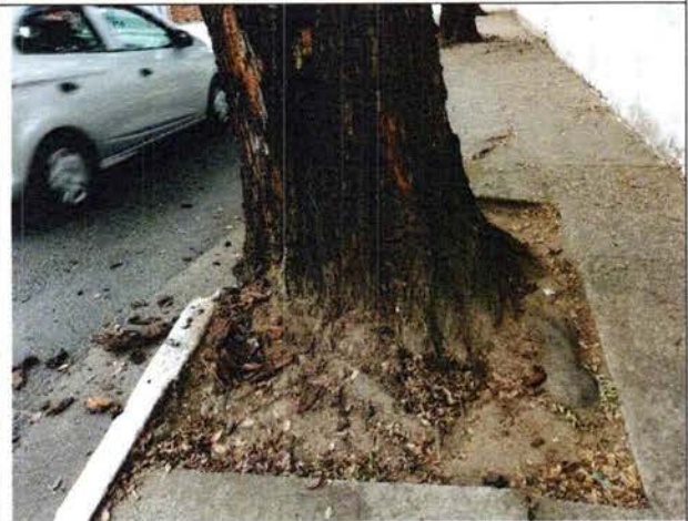
Foto 52. Danos leves na calçada.
