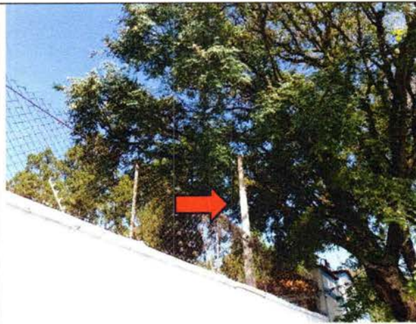
Foto 12. Conflito com poste padrão e fiação ramal.
