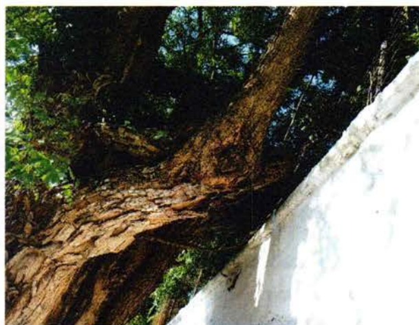
Foto 30. Dano na base da copa. Galhos biodeteriorado e desprendimento de casca.
