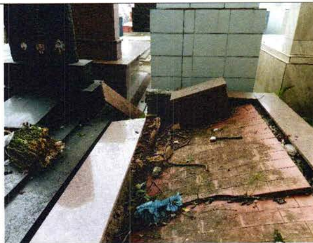
Foto 34. A tampa do jazigo deslocada e quebrada.
