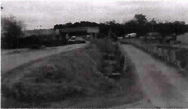
Rampa de acesso ao viaduto - Sentido Centro 3ª Ponte, centro.
