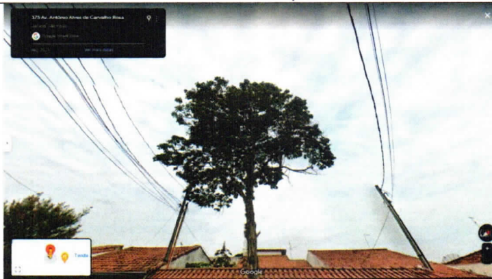
Imagem 3. Vista da copa da árvore, em dezembro de 2021 . Possível notar a fiação ramal nas laterais da copa, aparentemente sem conflito intenso (Fonte: Google Street View ).
