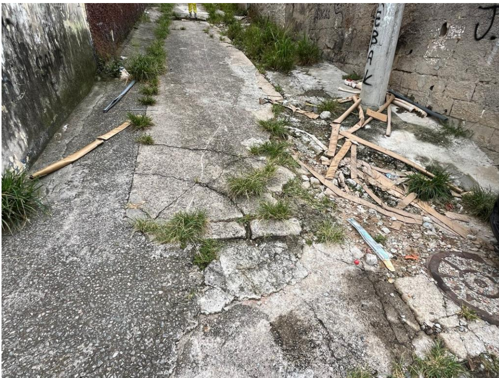
FOTO 6 – Viela localizada na Rua das Paineiras em frente ao nº 243.
