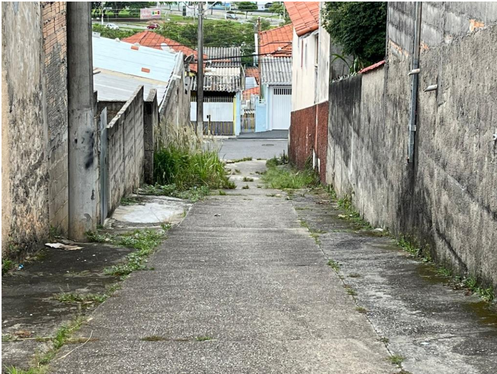
FOTO 3 – Viela localizada na Rua das Malvas em frente ao nº 208.
