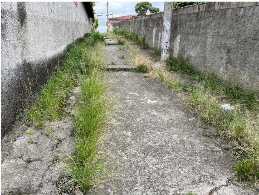
FOTO 4 – Viela localizada na Rua das Malvas em frente ao nº 153.
