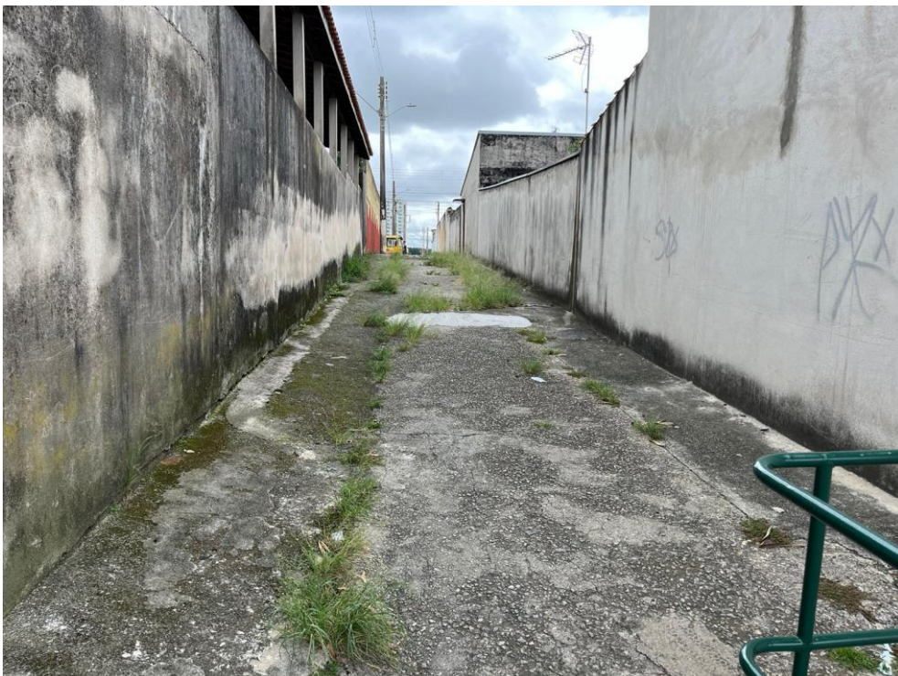
FOTO 2 – Viela localizada na Rua das Malvas em frente ao nº 315.
