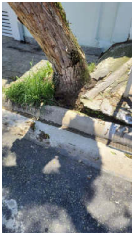
Figura 48: Exemplos de conflitos com a calçada encontrados nas ruas de Jacareí/SP.
