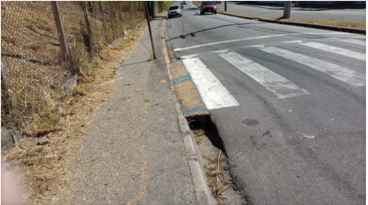
Foto 2: Exemplo de estrutura de faixa elevada, que inibe a manobra perigosa
