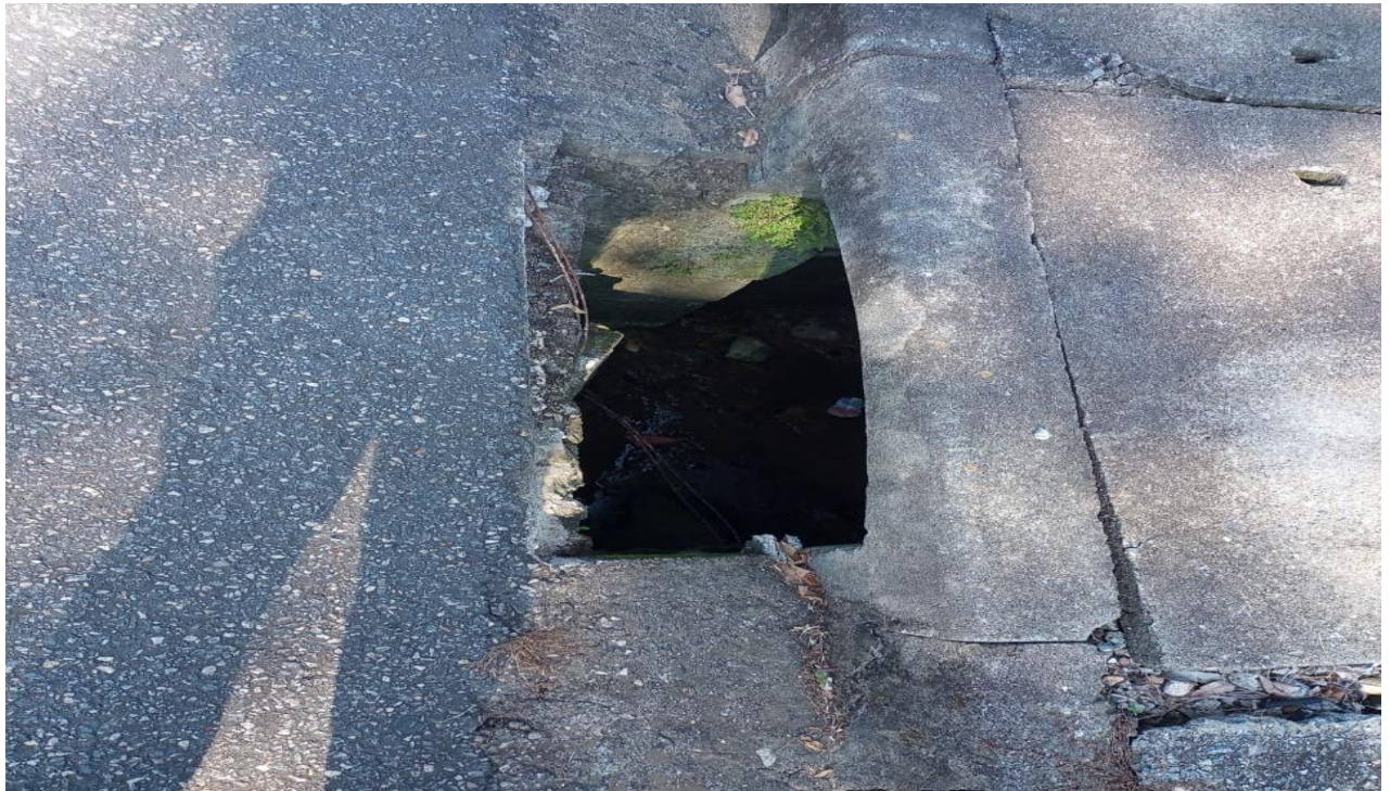
Imagem 1 - danos na BL e possível ausência de grade na boca de leão
