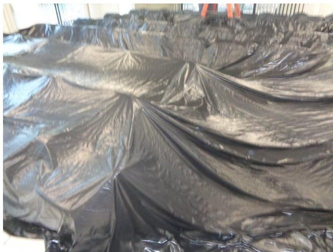
COBERTURA DO LOCAL (Foto 02)
