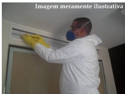
Técnico de Limpeza de Duto
