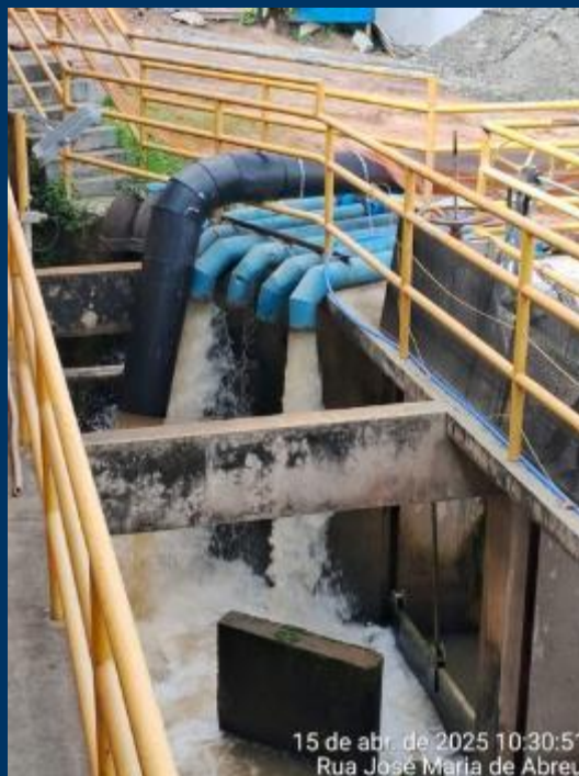
Tubos de queda de linha de recalque antigos
