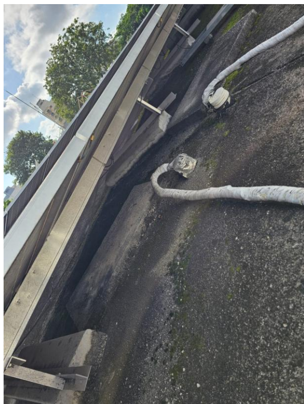
Figura 11: Suportes dos Painéis Fotovoltaicos
