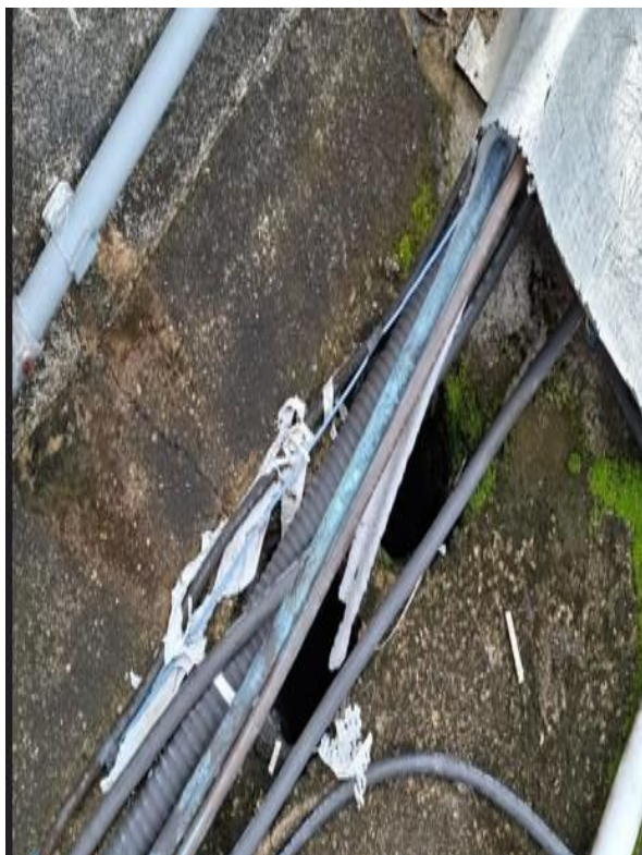
Figura 5: Caída de Água Existente
