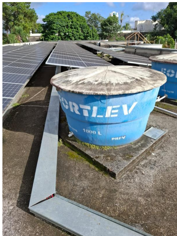
Figura 4: Caixa d'Água e Painéis Fotovoltaico
