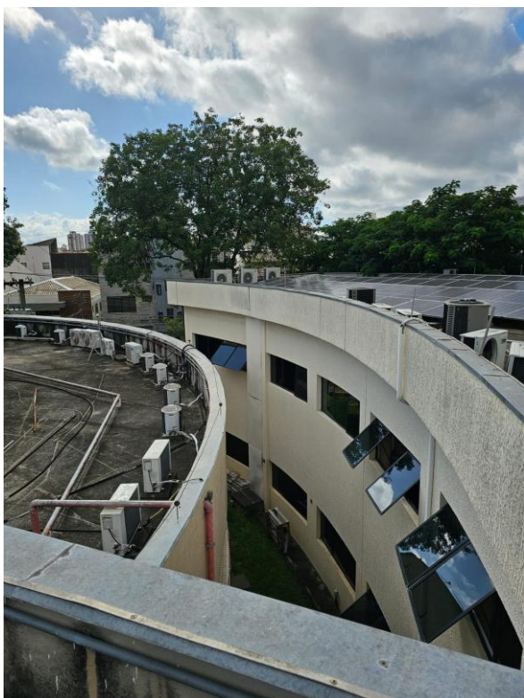
Figura 1: Foto Lateral da Laje
