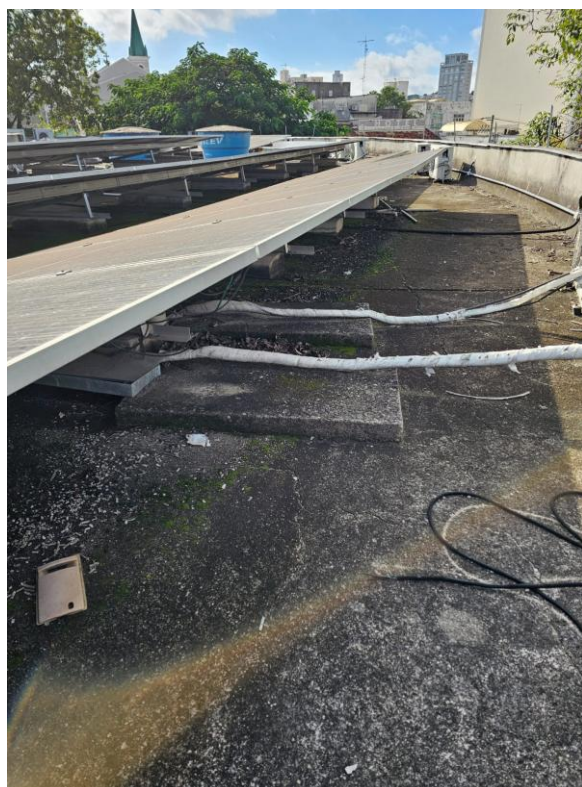
Figura 2: Foto da Laje
