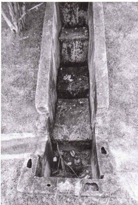
Foto 11: Escada hidráulica obstruída por vegetação
