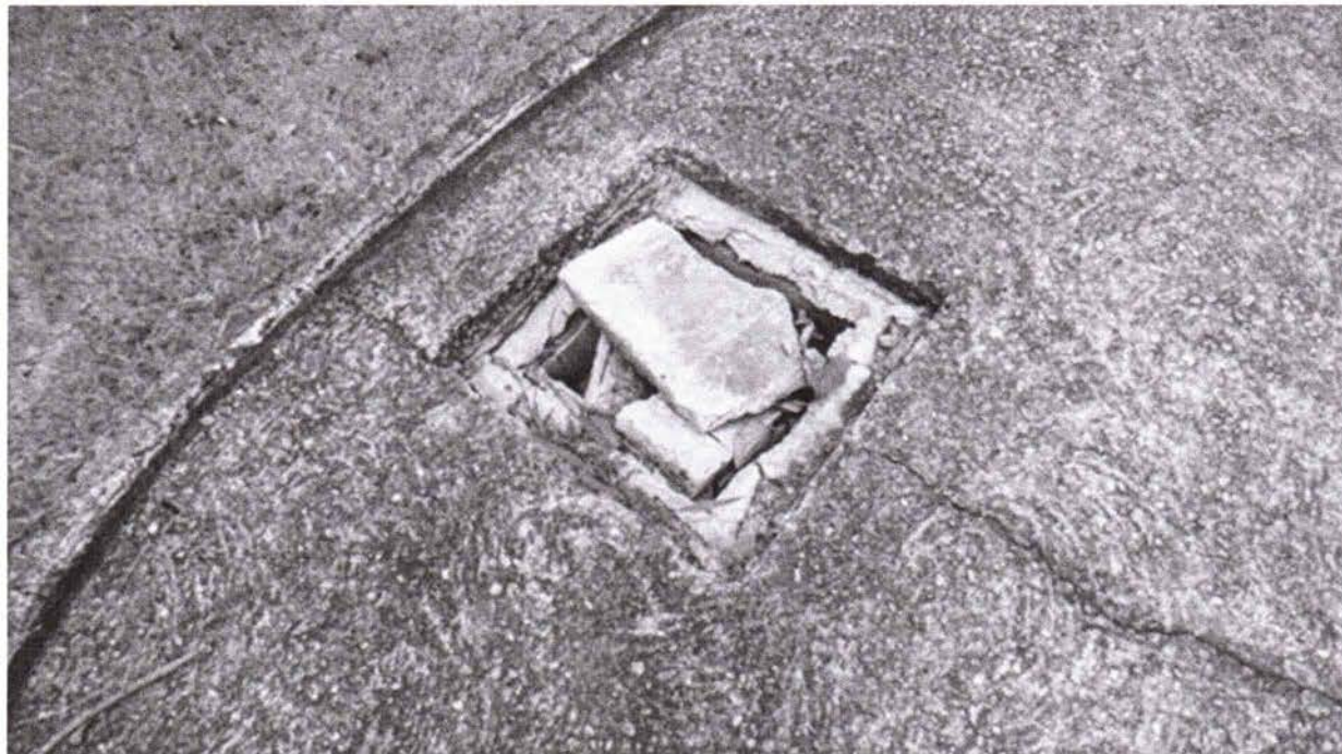
Foto 5: Caixas de alvenaria com tampas quebradas
