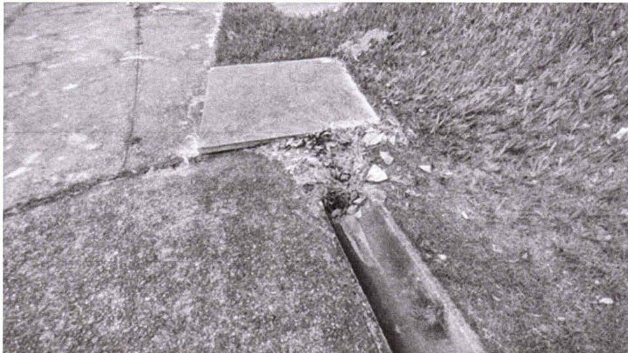
Foto 8: Canaletas de escoamento de água obstruídas
