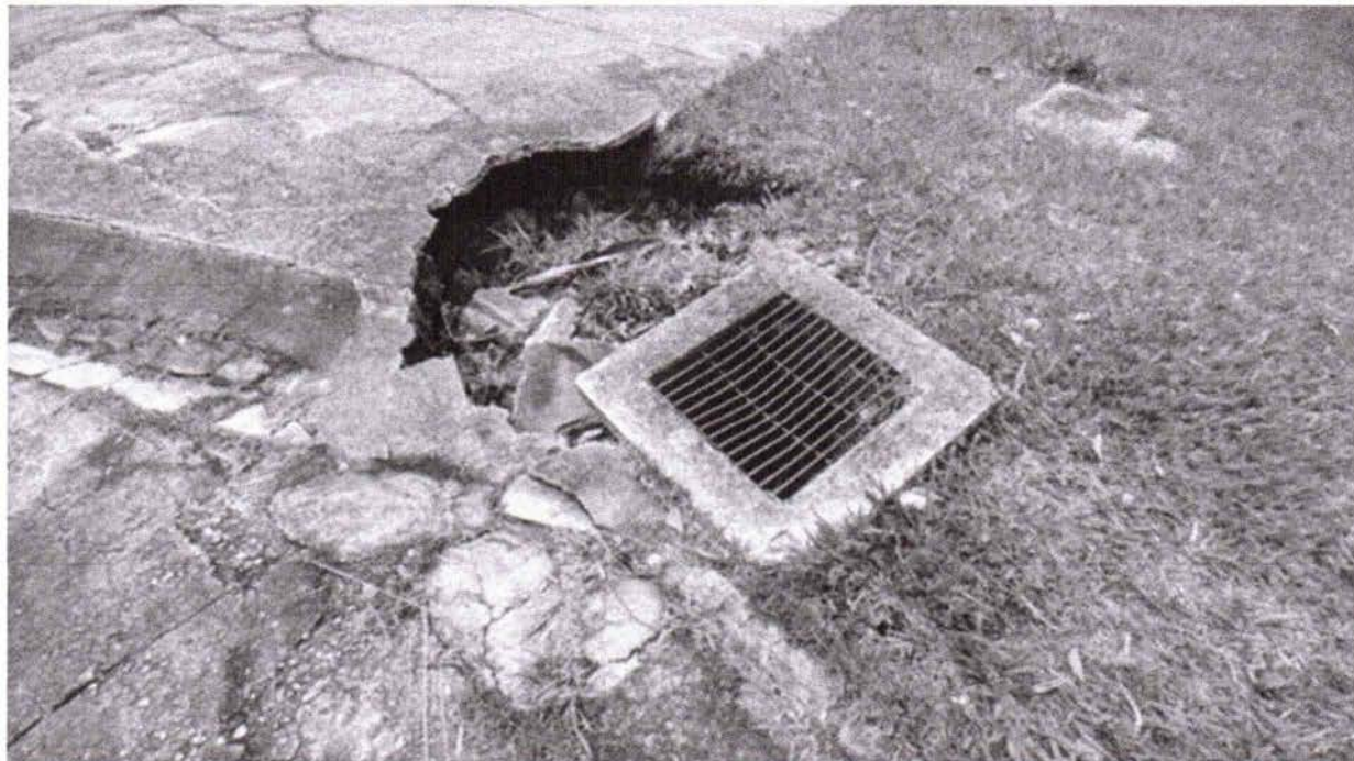
Foto 3: Piso “oco” com afundamento
