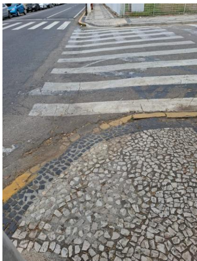
Foto 19: Rampa de Acesso
