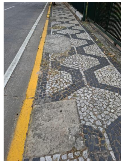
Foto 12: Caixas de Inspeção
