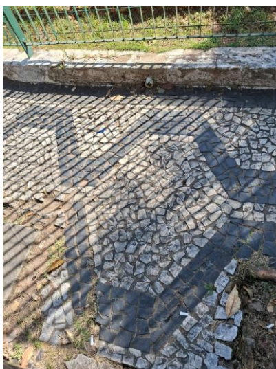
Foto 25: Ponto de Drenagem
