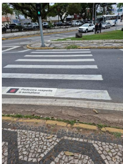
Foto 13: Rampa de Acesso
