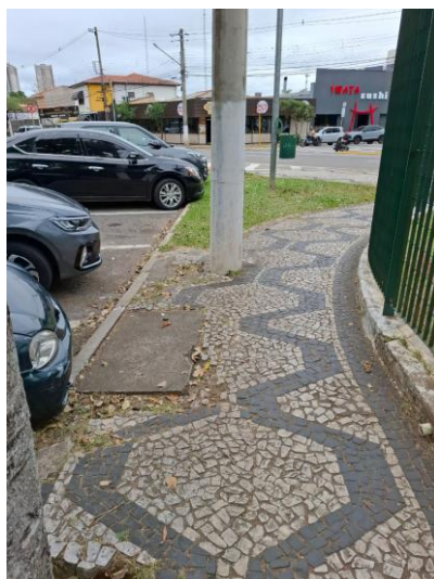
Foto 2: Boca de Lobo
