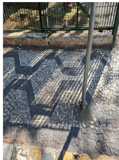
Foto 24: Ponto de Drenagem
