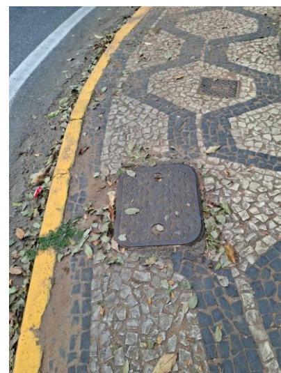
Foto 15: Caixas de Inspeção
