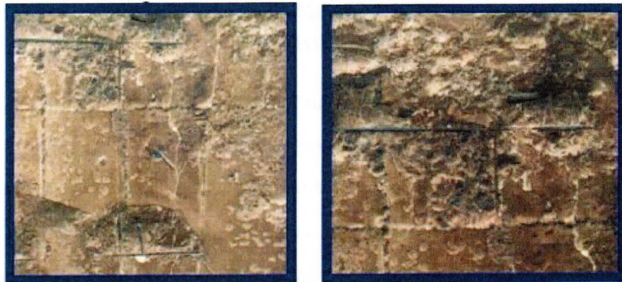
Imagem 3 - Pontos com lascamento (spalling)
