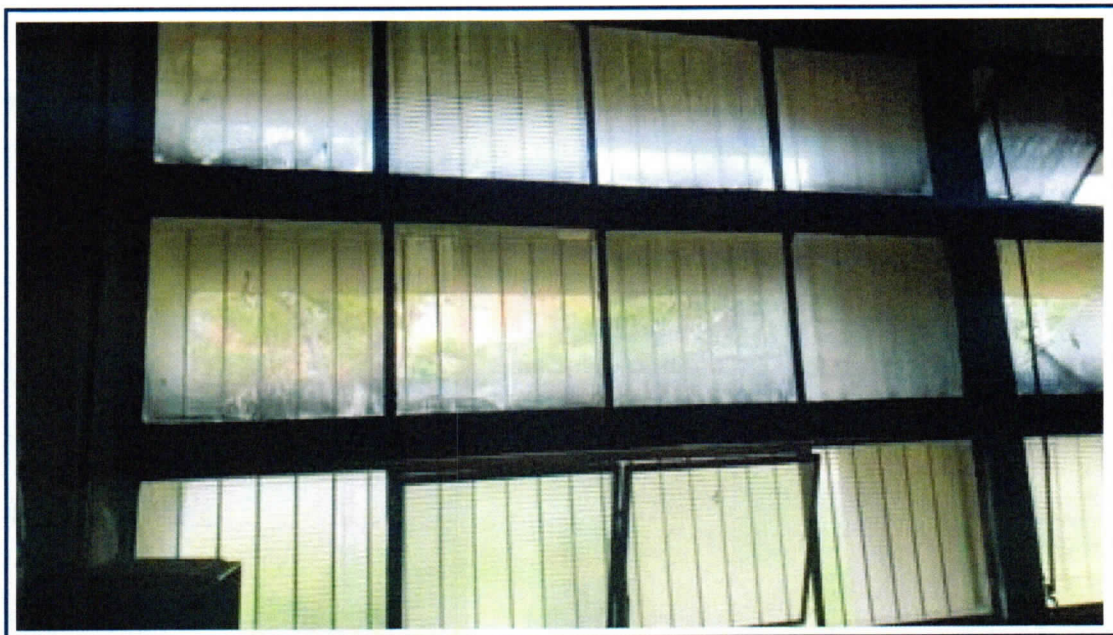
Foto 19: Vista da esquadria de ferro em boas condições de funcionamento, sem vidros quebrados, sinal de que não teve a estrutura danificada pelo incêndio.
