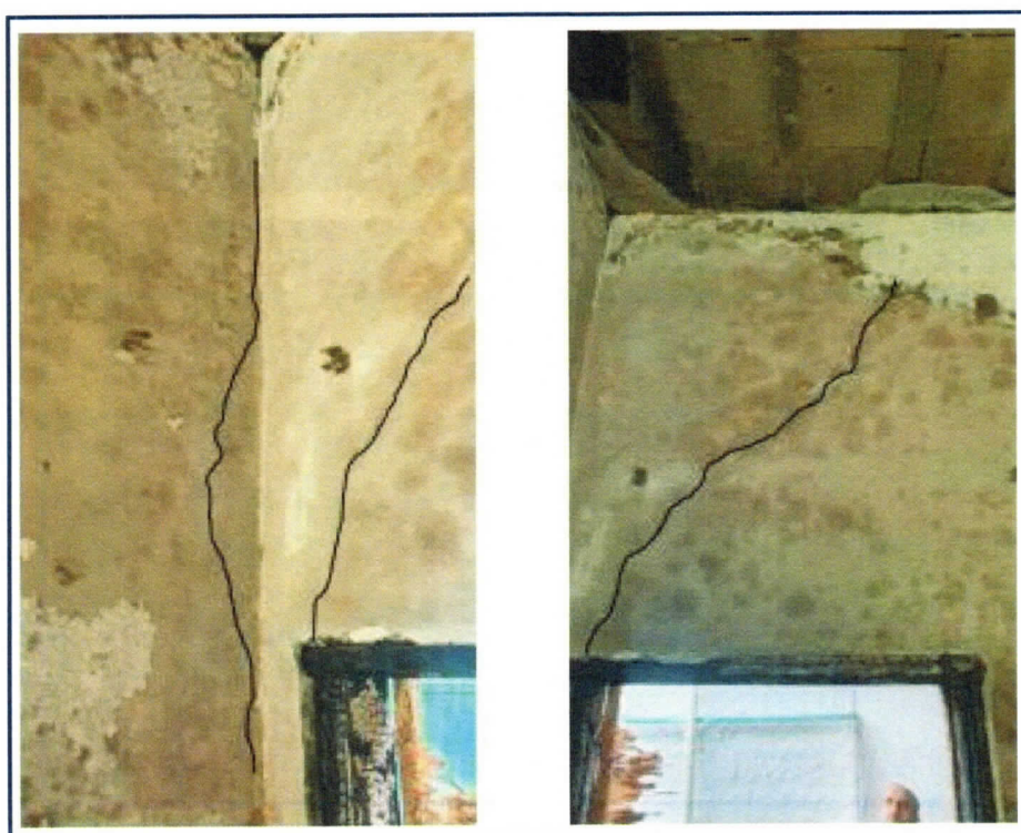
Foto 31: Paredes de alvenaria com fissuras decorrentes da dilatação térmica da laje.
