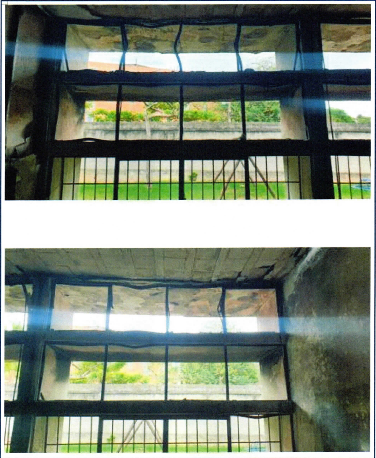
Foto 27: Vista das esquadrias de ferro danificada pela ação do fogo. Observa-se também o colapso das vigas treliçadas da laje. Estima-se que a temperatura atingiu cerca de 700° C nessa região.
