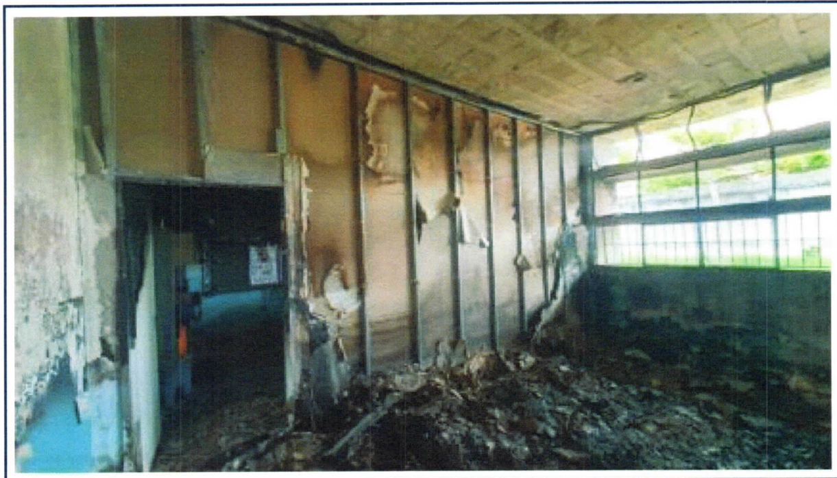
Foto 25: Vista da parede de drywall [gesso acartonado] que divide a sala 9 (professores) com a sala de materiais de educação física destruída pela ação do fogo, que se originou na porção inferior direita.
