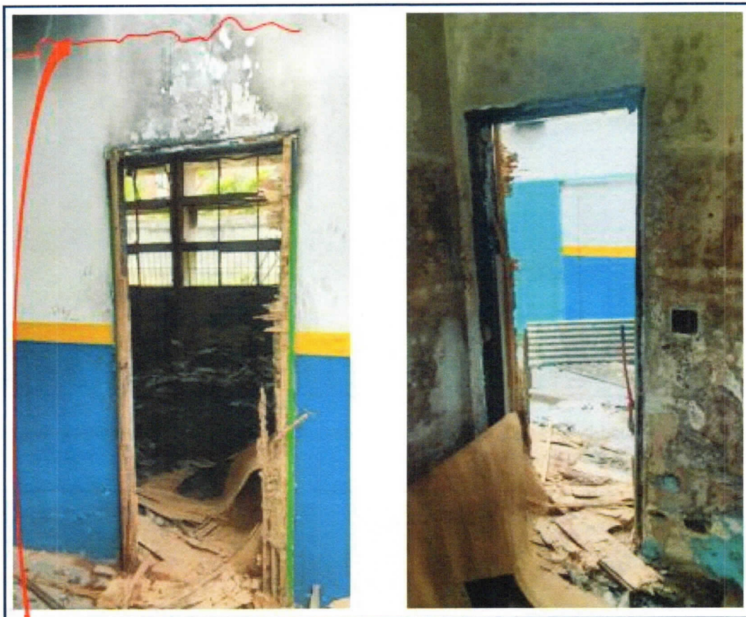
Foto 21: Vista da porta de entrada totalmente destruída. A imagem à esquerda apresenta “fissuras” de dilatação da laje devido a alta temperatura no local.
