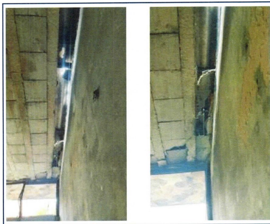
Foto 30: Outra vista da laje treliçada com os elementos estruturais danificados pela ação do fogo, além de ficar sujeita ao intemperismo.
