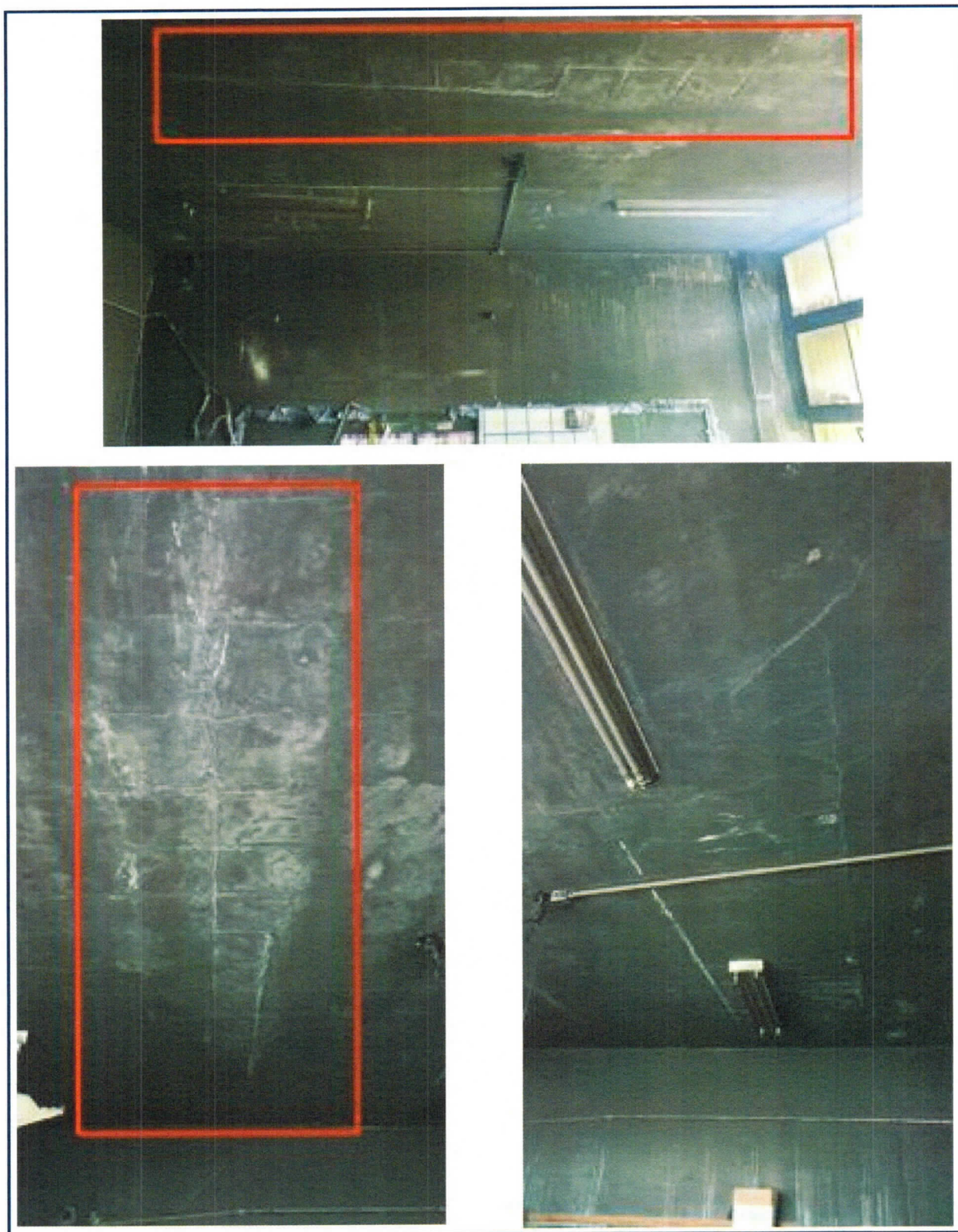
Foto 15: Vista do teto e parte superior da parede com grande concentração de fuligem decorrente da fumaça preta. Observa-se fissuras no revestimento da laje devido a dilatação pela variação de temperatura.
