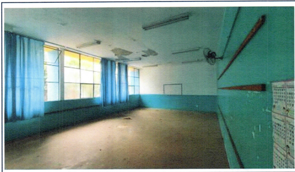
Foto 4: Visão geral da sala sem vestígio de incêndio. Observa-se que a pintura do forro está descascando devido às infiltrações de água de chuva pelo telhado.
