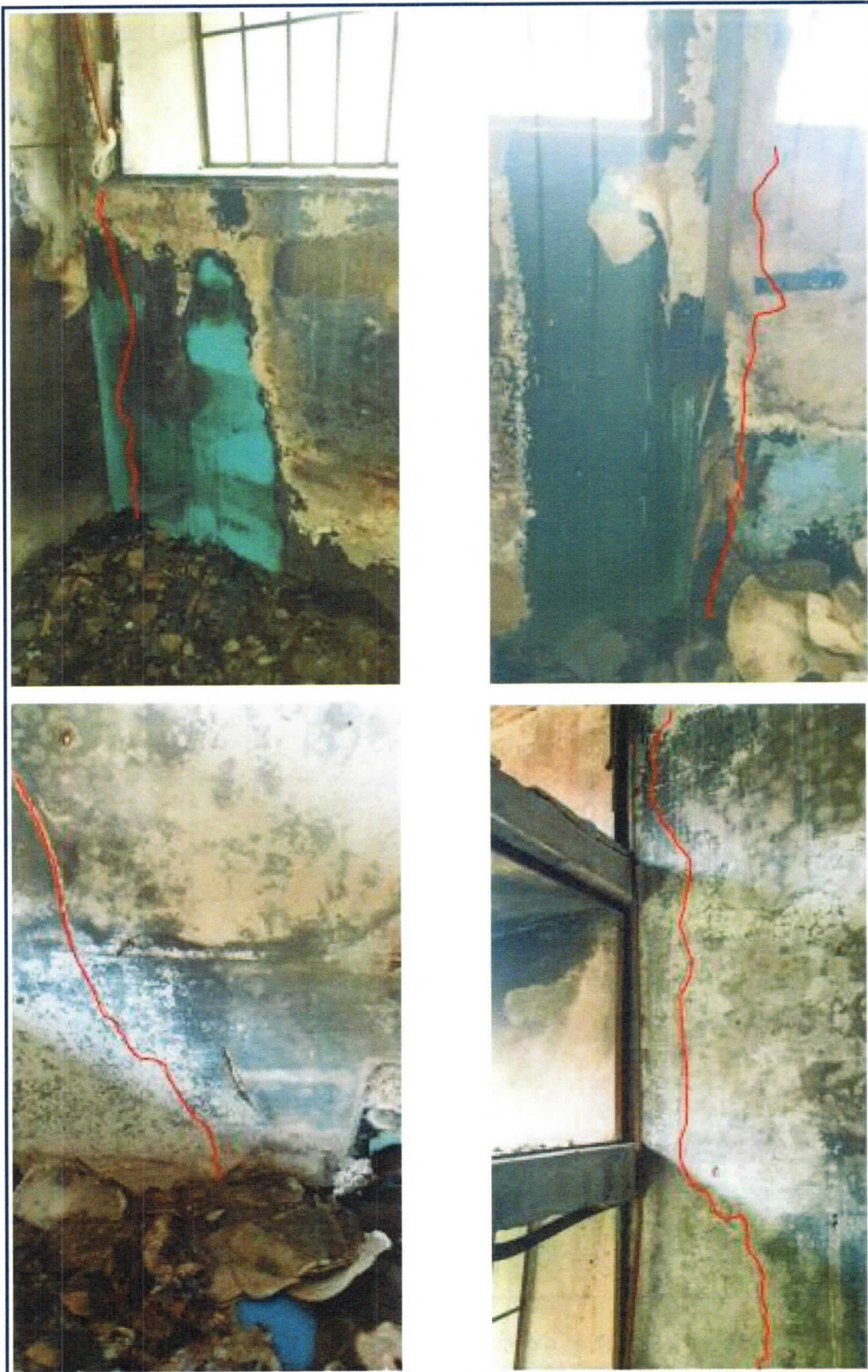
Foto 28: Vista da parede de alvenaria com trincas na interface com a esquadria de ferro, por dilatação térmica, anterior ao incêndio.
