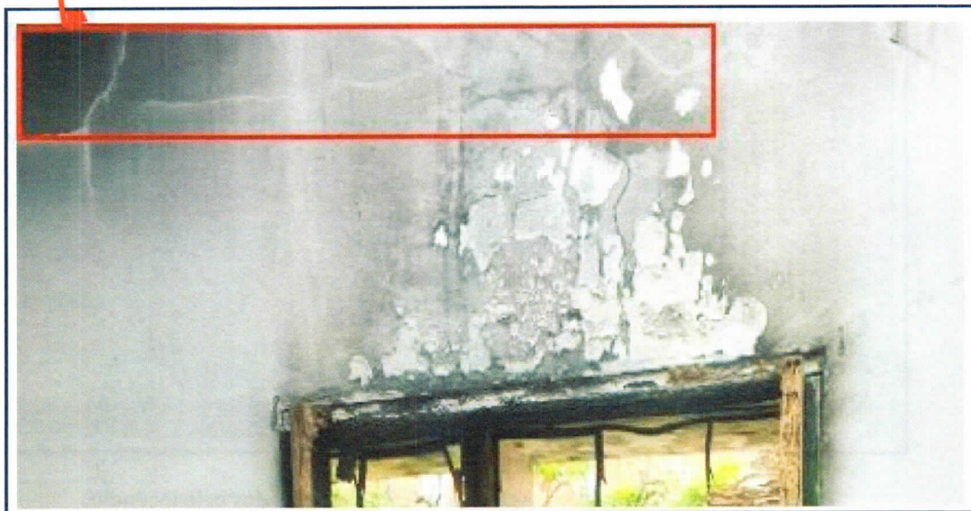
Foto 22: Detalhe da fissura na parede de alvenaria, resultante do movimento de dilatação da estrutura da laje.
