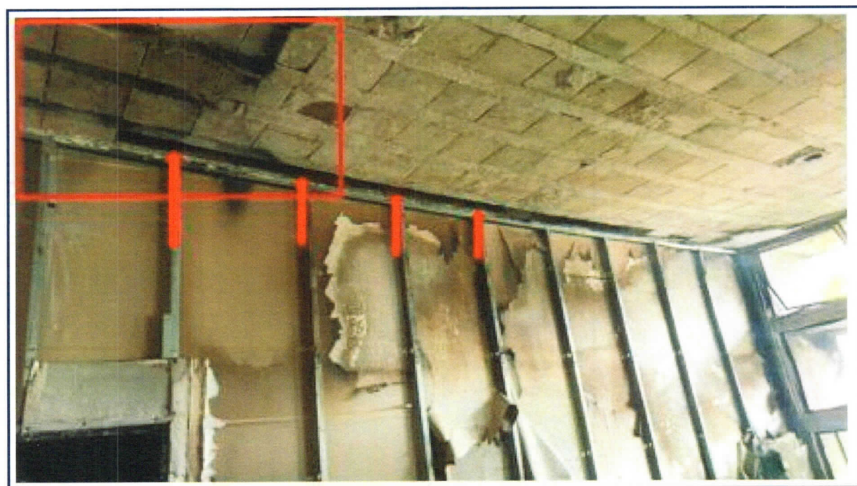
Foto 26: Vista do trecho afetado pelo incêndio – observando o deslocamento total do revestimento (reboco) do teto, e do cobrimento de concreto da viga treliça da laje, assim como os pontos de pipocamentos na superfície do concreto, estima-se que a temperatura nesse ambiente foi da ordem de 700° C, tendo em vista que danificou a esquadria de ferro.
