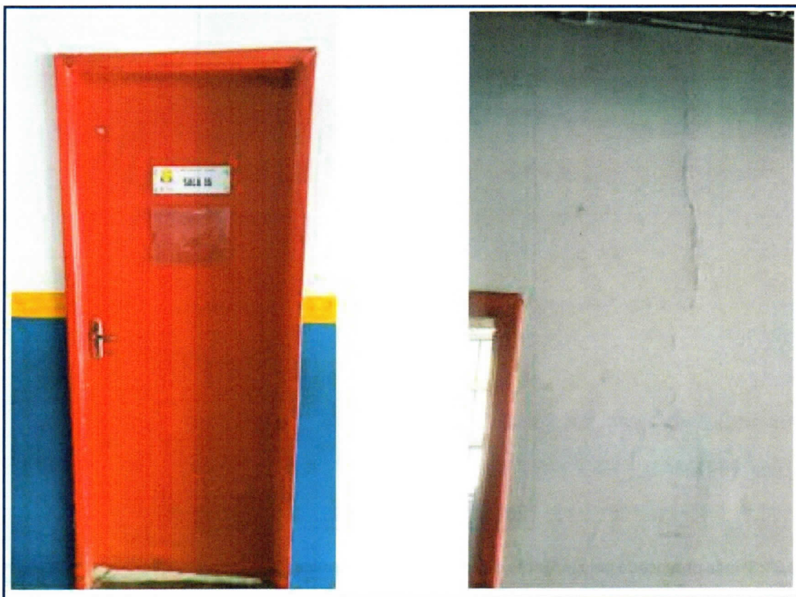
Foto 32: Vista da parede de alvenaria com trinca vertical, ao lado da porta, anterior ao incêndio.
