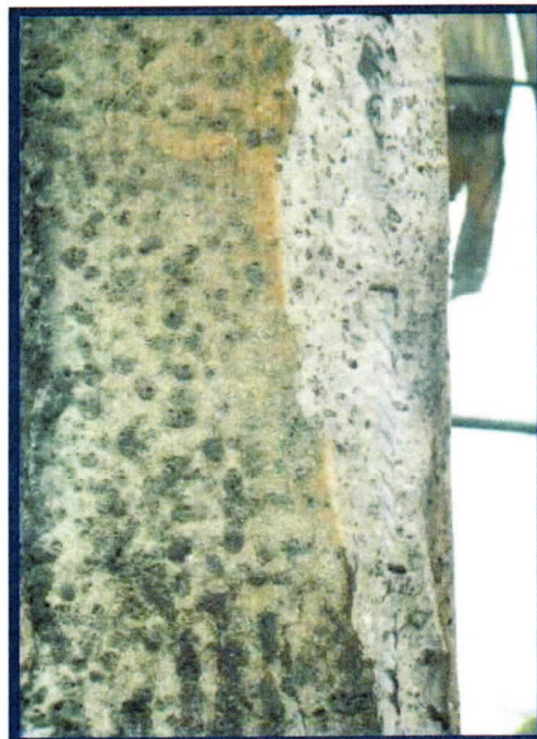
Imagem 5 - Local onde houve "pipocamento" do concreto fazendo-o esfarelar
