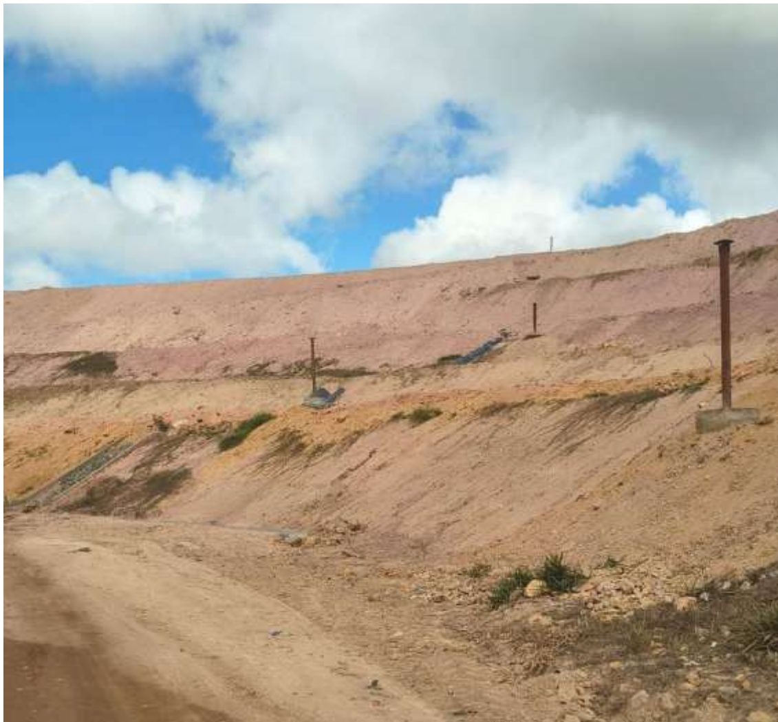
Figura 9: Trechos do aterro sem cobertura vegetal e flares apagados
