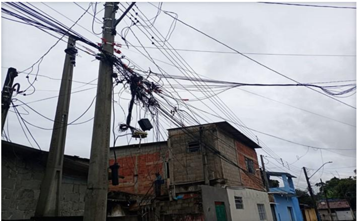
Foto 2: Após a troca de poste
