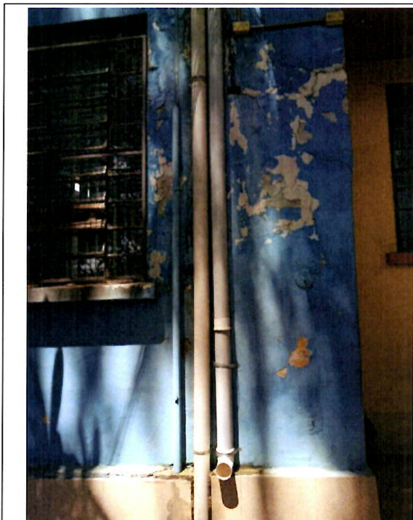
Foto 1: Fachada do prédio escolar.
