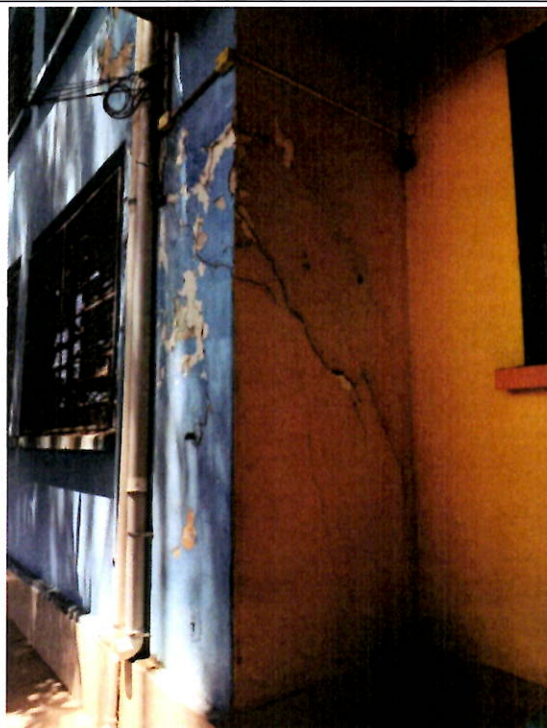
Foto 2: Fachada do prédio escolar.
