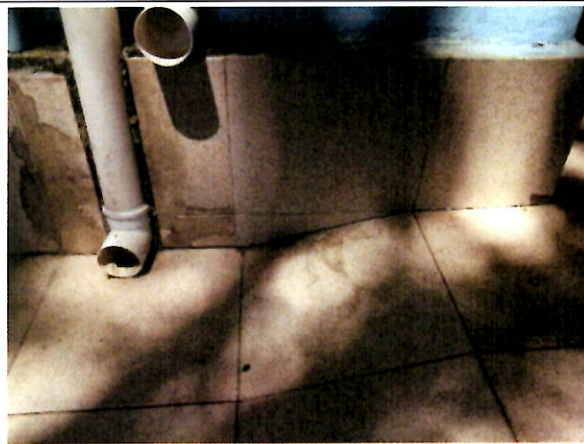
Foto 6: Fachada do prédio escolar, detalhe do piso.
