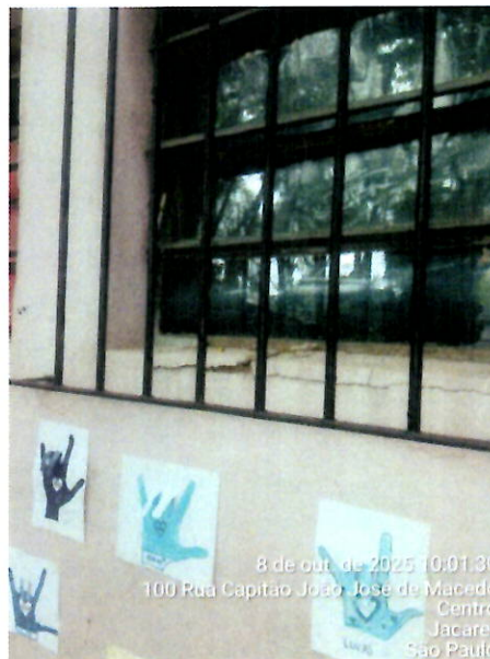
Foto 14: Afundamento do piso, resultando na separação da alvenaria da parede com o piso, projetando um vão entre as partes.
