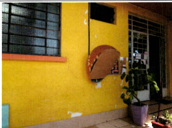
Foto 5: Fachada do prédio escolar.
