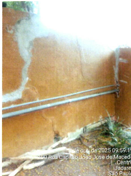
Foto 10: Mais pontos com problemas de trincas e rachaduras, no espaço externo, sugerindo que há movimentação do solo na área externa ao prédio vistoriado.
