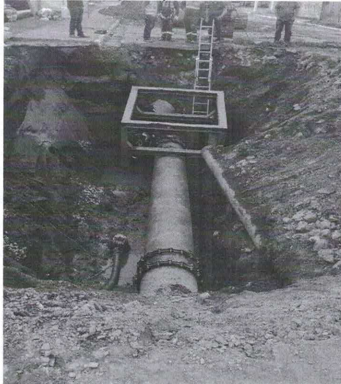
Figura 12: Montagem da junta mecânica
