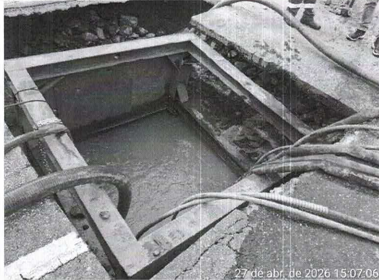
Figura 7 e 8: Esgotamento de vala
