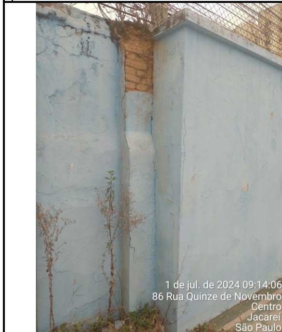
Foto 05: Apesar da rachadura e da umidade, o muro permanece em perfeitas condições de nivelamento e estabilidade;
