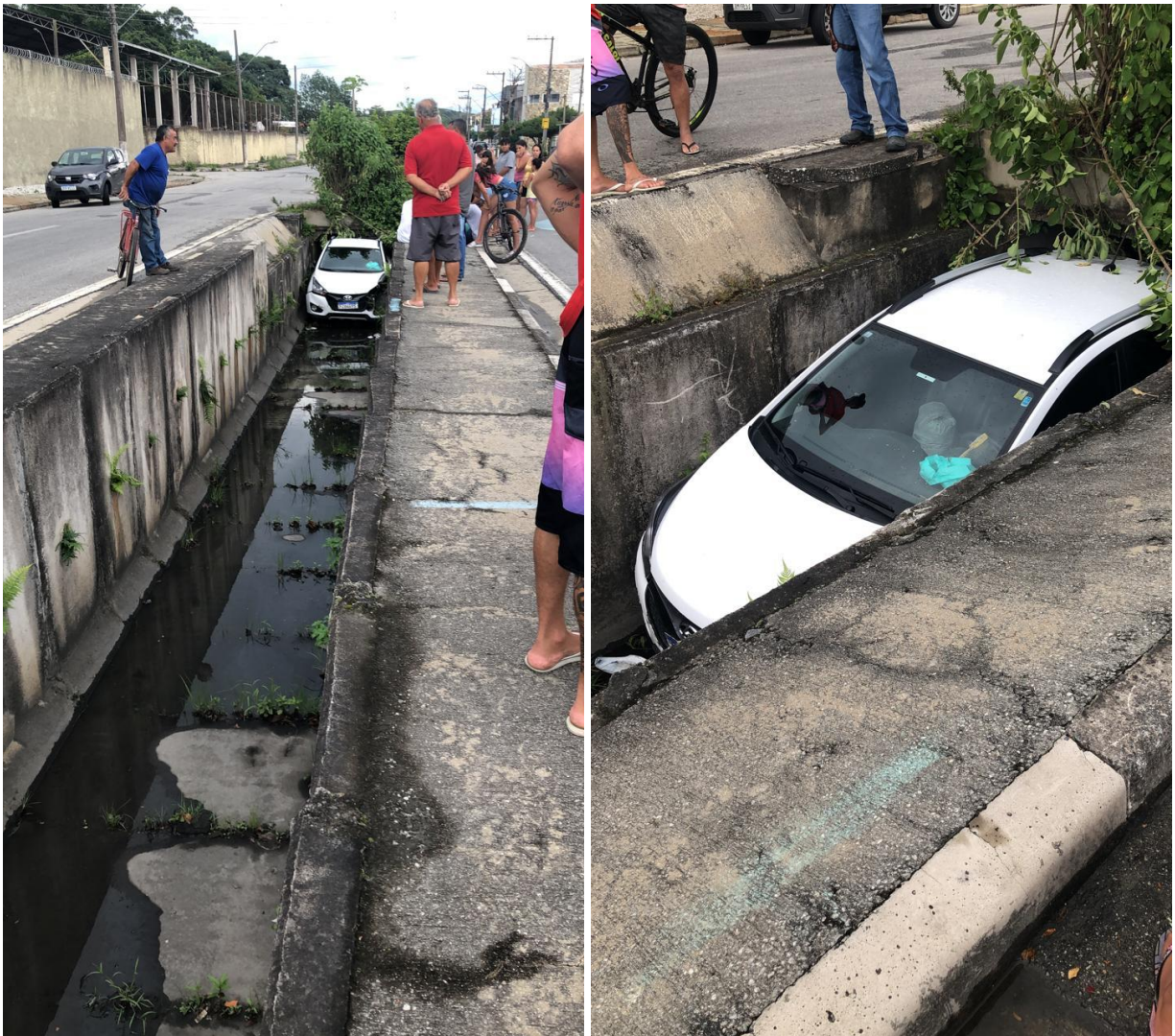
Fotos 1 e 2: registro de ocorrência na valeta da Avenida dos Migrantes
